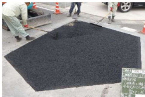
土木緊急修繕
