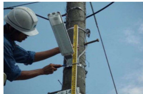
街路灯の修繕
