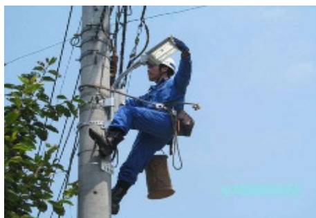
【道路照明灯の修繕】
