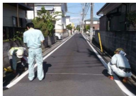
【道路緊急修繕】
